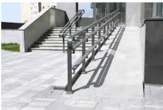
Εικόνα 4-5: Παράδειγμα ράμπας με χειρολισθήρα σε υφιστάμενη κλίμακα
